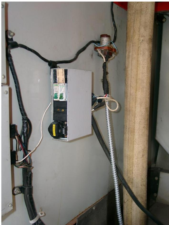
Рисунок 2.3 – Пульт управления с элементами электрозащиты и коммутации.
